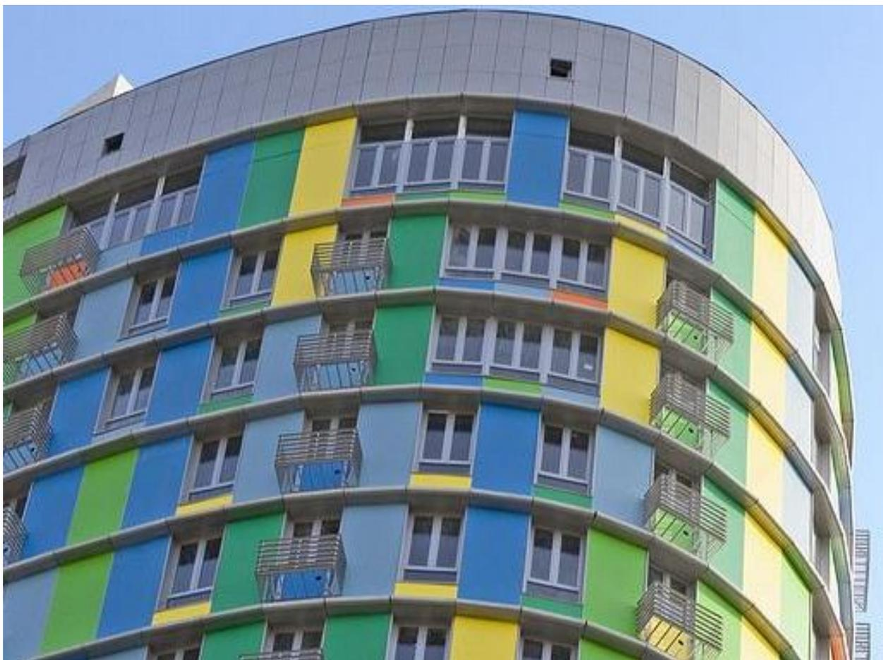
*Под окнами каждой квартиры предусмотрены металлические корзины для внешних блоков сплит-систем. В наружных стенах имеются отверстия для труб и кабелей, в которые вставлены металлические гильзы, закрытые цветными заглушками...*
