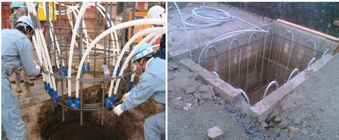
Рис. 4. Закладка грунтовых зондов в сваи и элементы фундамента
